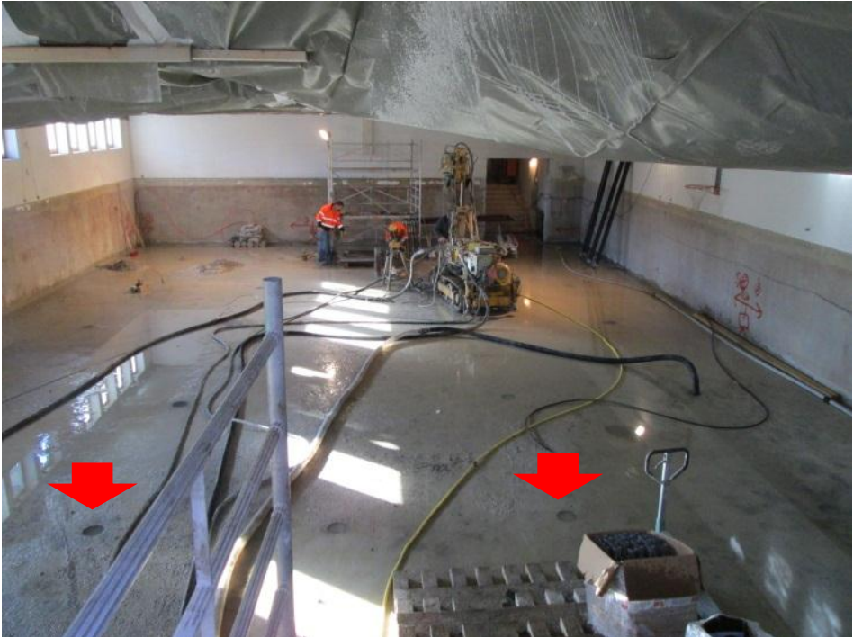
Spülbohren für Anker
