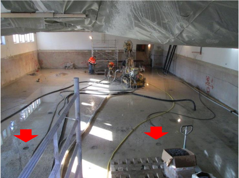
Spülbohren für Anker
