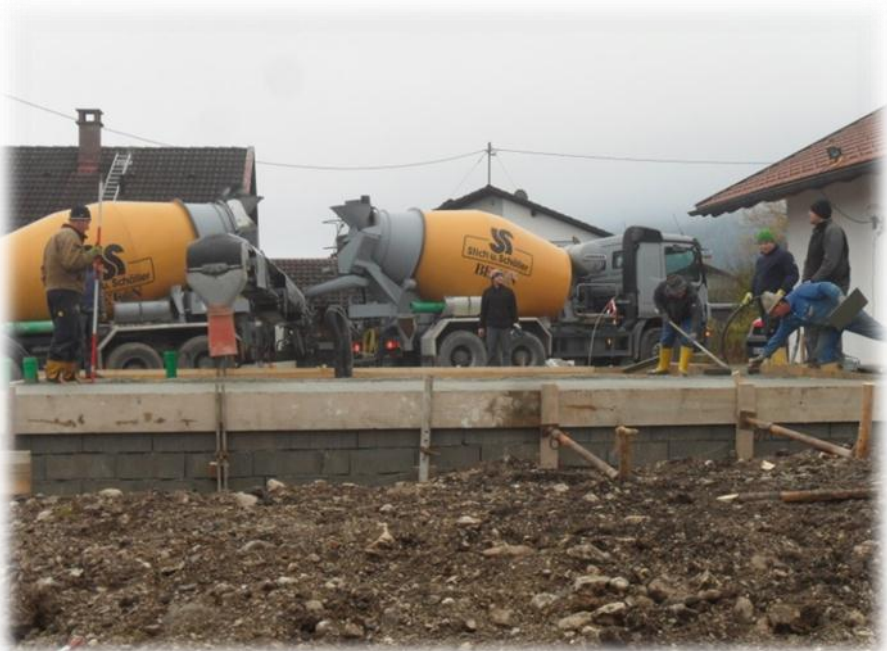
Bauarbeiten an der neuen Bergrettungswache
