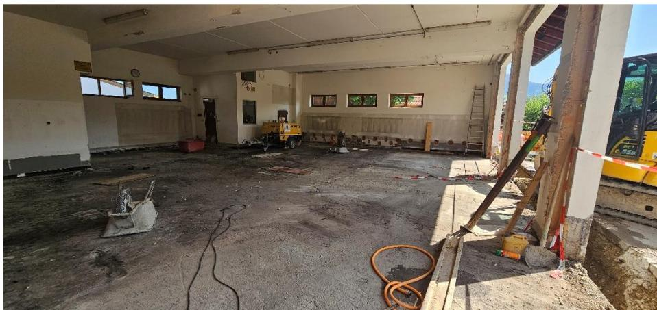
Ende Juni wurden die neuen Ablaufrinnen und Anschlagschienen gesetzt, die Decke geweißelt und der Ausgleichsestrich eingebracht. Mitte Juli folgten die Bodenabdichtung sowie der neue Belag aus Gussasphalt. Parallel dazu wurden die Installations- sowie Elektroleitungen neu verlegt.
